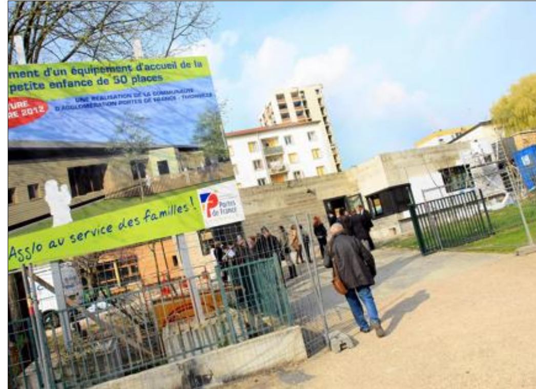
Le multi-accueil Les Petits de la Colline est en construction à Thionville, à la Côte-des-Roses. Il devrait accueillir cinquante enfants dès le mois de septembre. Photo RL
