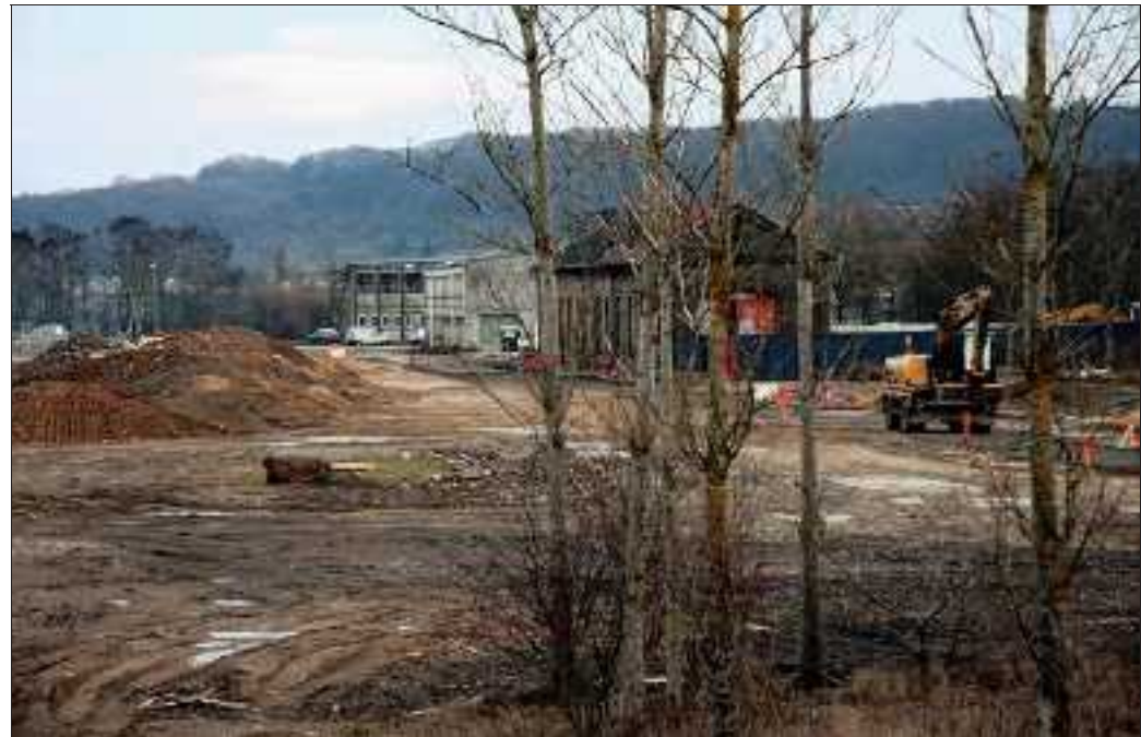
Débutés en décembre dernier, les travaux de viabilisation d'une zone d'activité économique sur le bas de Micheville arrivent à terme. Photo archives Julio Pelaez
