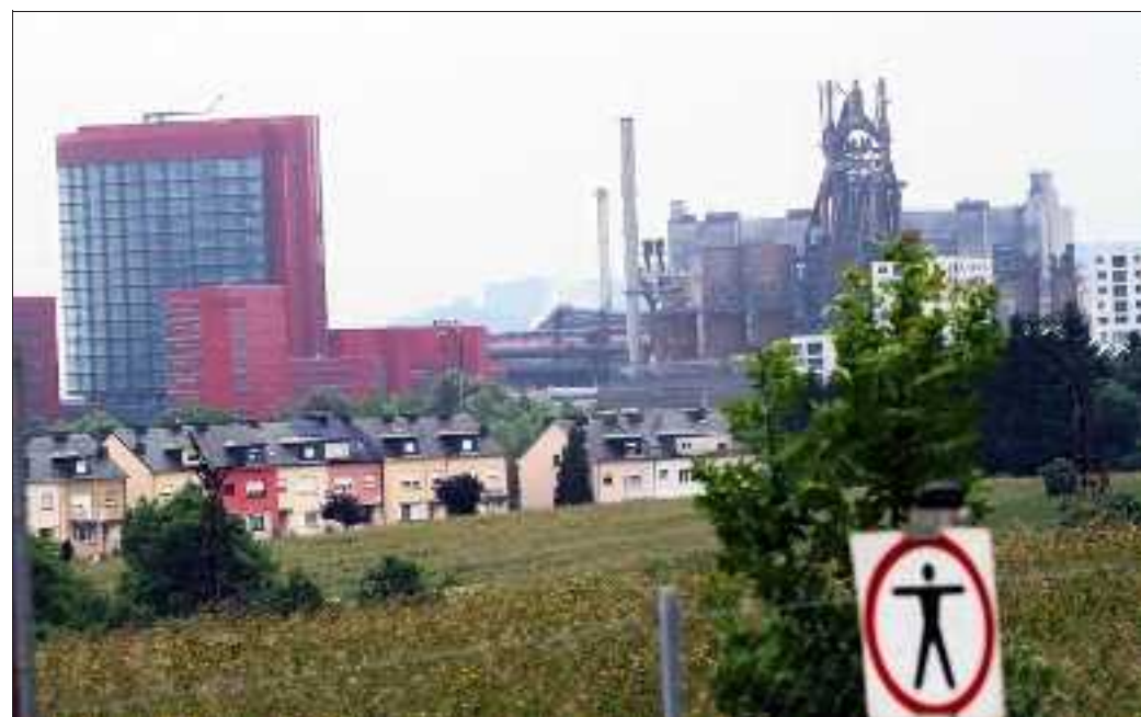
Depuis la halte ferroviaire Belval - Rédange, on aperçoit, entre le bâtiment rouge de la Dexia et le haut-fourneau B, l'un des fours électriques qui devrait être alimenté par la ligne 225 000 volts. Photo Julio PELAEZ
