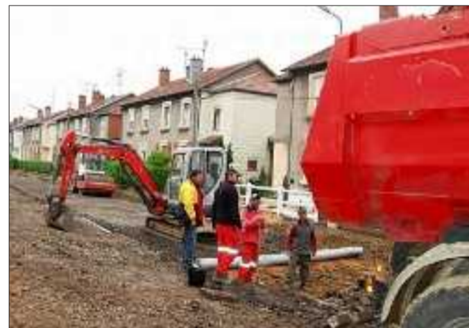
Les engins de chantier sont en action rue de la Liberté, la circulation est temporairement bloquée, les riverains garent les voitures dans les rues voisines. Photo RL
